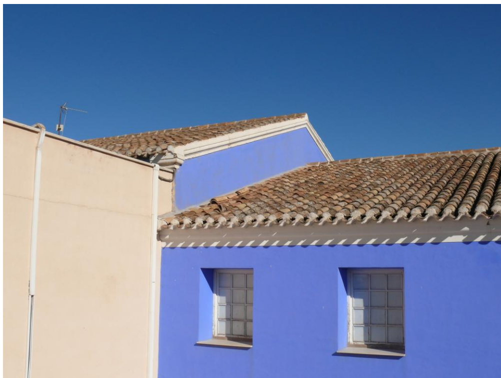
Cubierta del teatro objeto de rehabilitación
