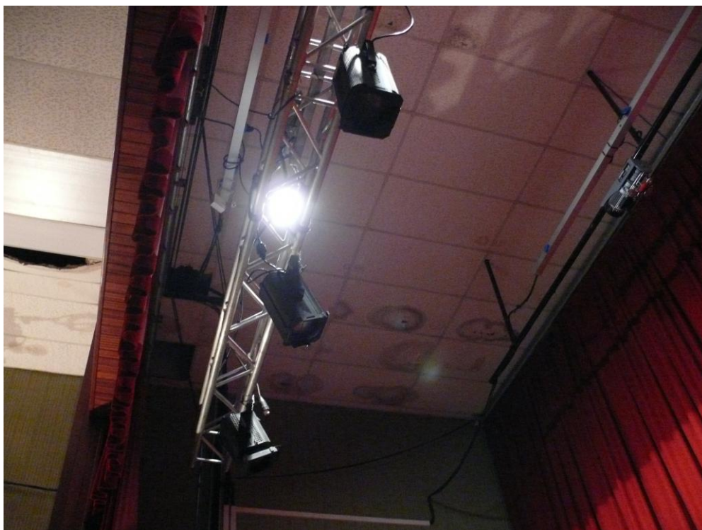
Falso techo del teatro e iluminación del escenario
