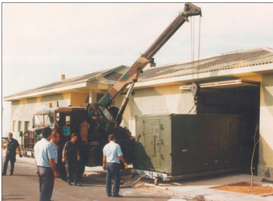
Instalación del Shelter de Equipos en el edificio de la EVA 13
