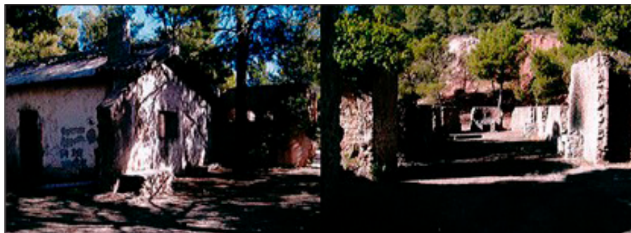
Estado actual de la casa del Avión en el Parque Natural de Sierra Espuña
