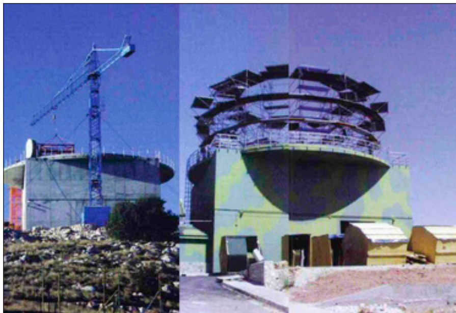
Fases de construcción del edificio Radar
