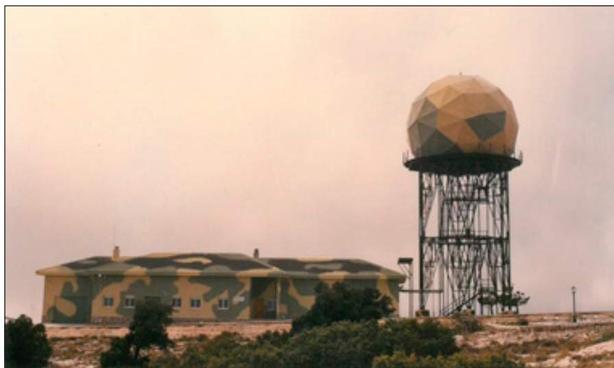
La EVA-13 en noviembre de 1994, con el radomo instalado pero sin radar en él
