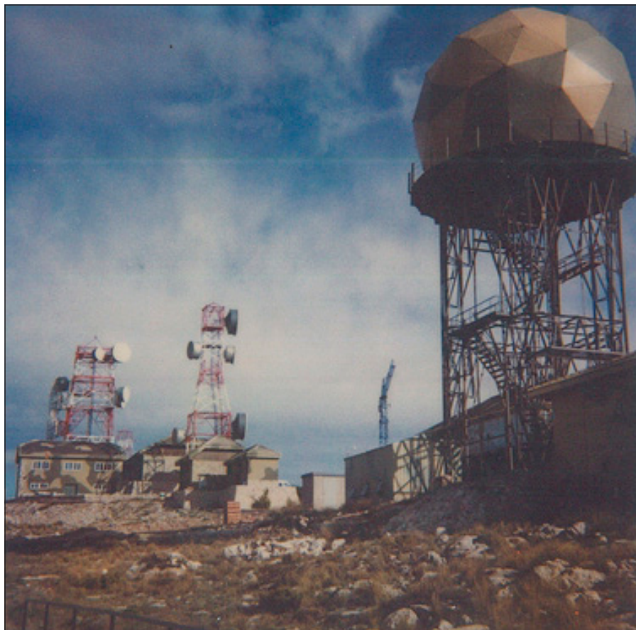
La EVA 13 con su radar ya operativo dentro del CT-5
