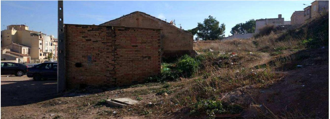
Almacén 1 (vista lateral) y almacén 2 de fondo. Se ve el poste de la luz existente, que no está adosado a la edificación, pero habrá que tener la precaución de que no se vea afectado en la demolición.
